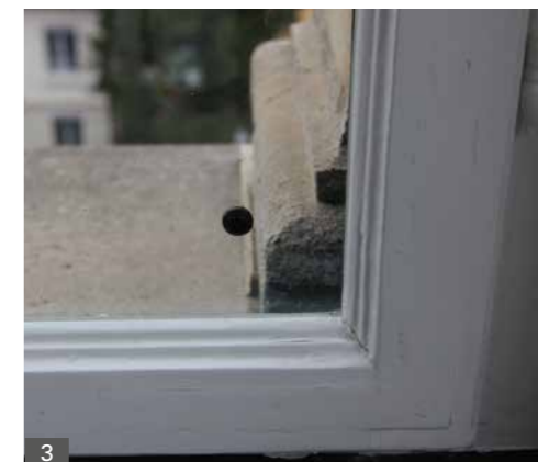
Abb. 3 Zürich, Parkring, Kantonsschule, 2016: Fenster mit Evakuierungsstößen.
