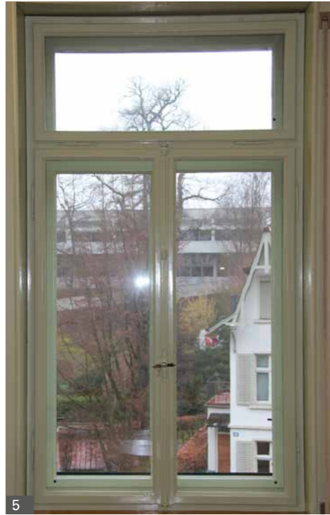
Abb. 5 Zürich, Parkring, Kantonsschule, 2016.
