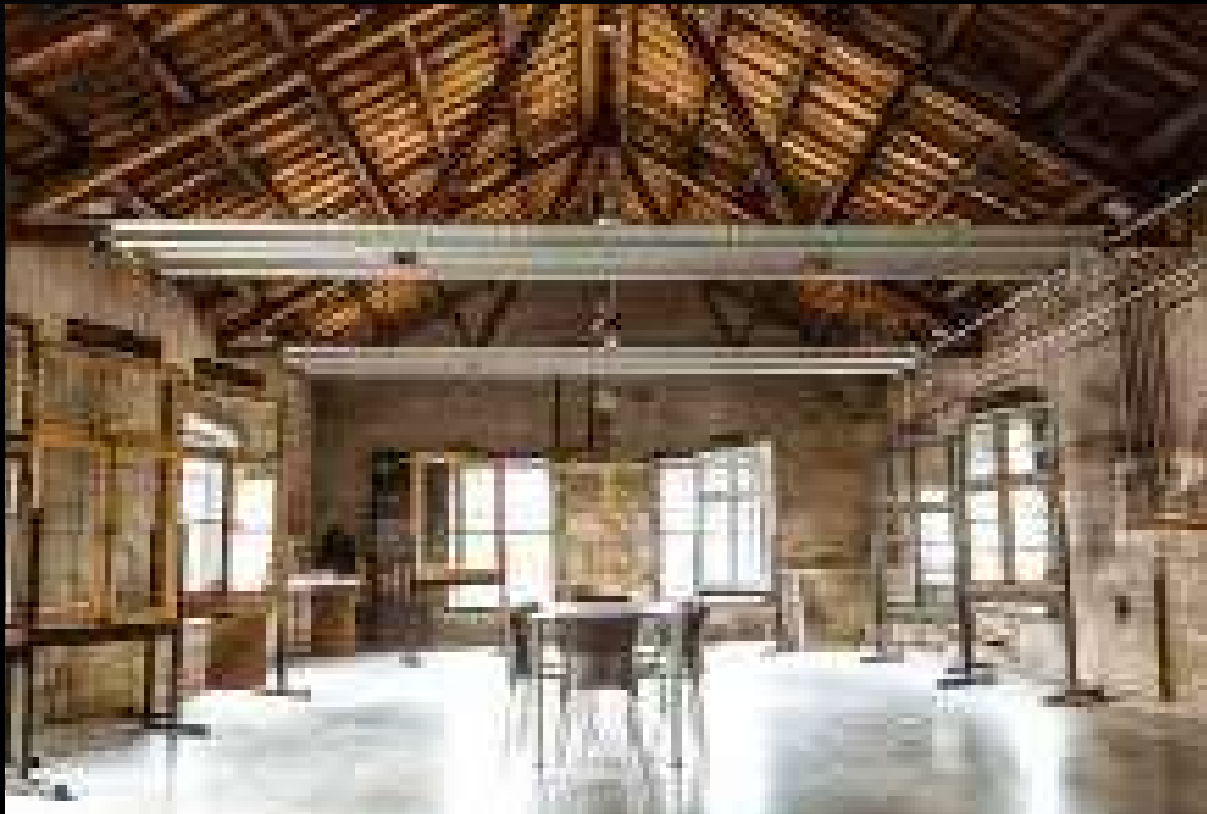
Galerie im Pumpenhaus
