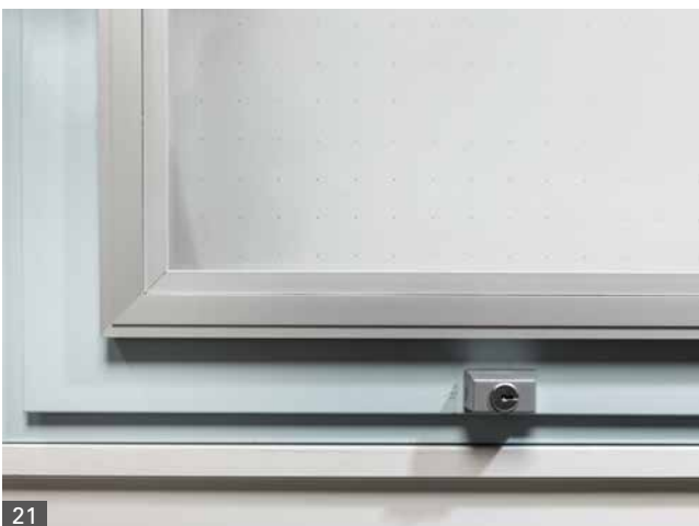
Abb. 21 Unterer Fensterrahmen mit integriertem Schließzylinder und erkennbarem Vakuumisolierverglas
