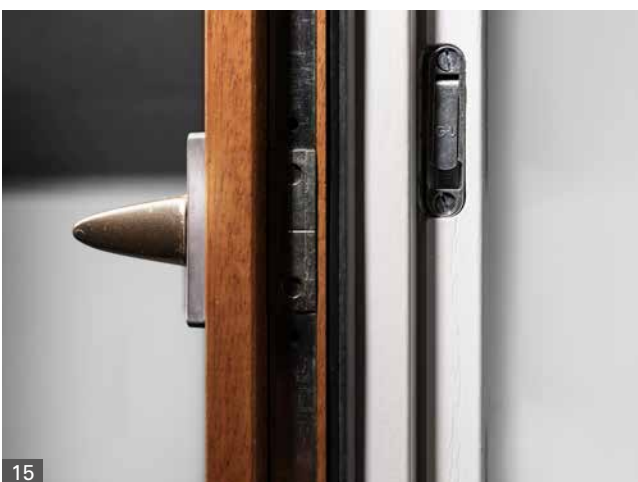
Abb. 15 Bestehender Rahmen mit additivem außen liegendem Aufsatzflügel
