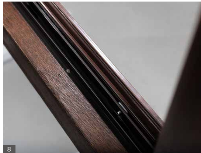
Abb. 8 Detailsicht der Falzgeometrie
