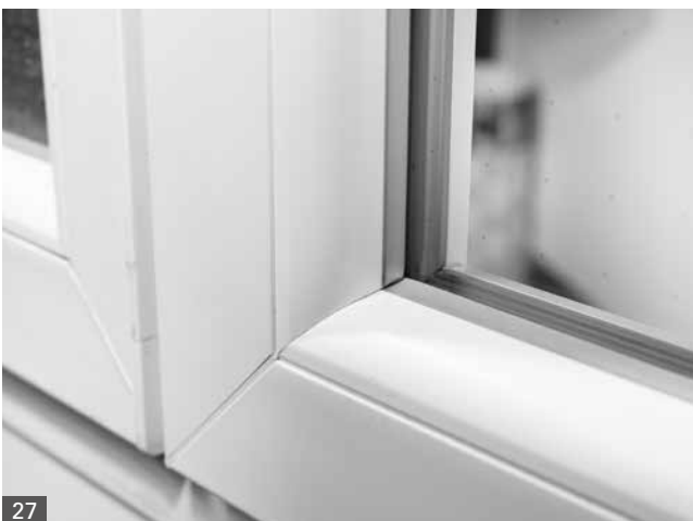
Abb. 27 Innenansicht der Rahmenecke mit erkennbarer Punktmatrix der Vakuumisolierverglasung
