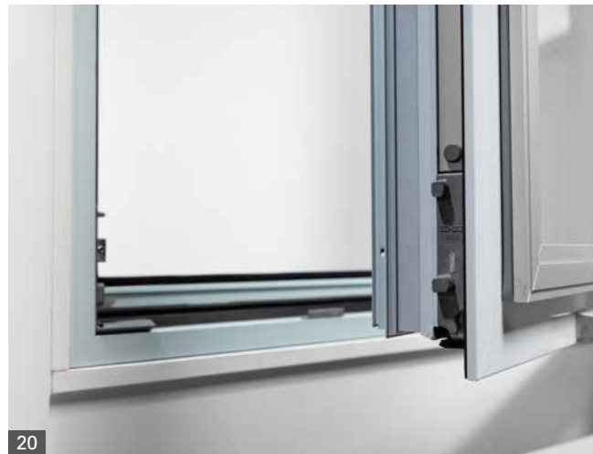
Abb. 20 Bestandsrahmen mit additivem innen liegenden Aufsatzflügel
