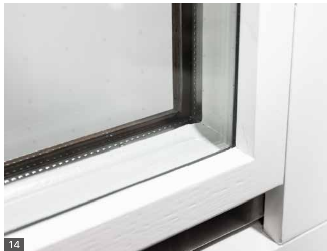
Abb. 14 Bestandsglas und außen liegendes Vakuumisoliervglas
