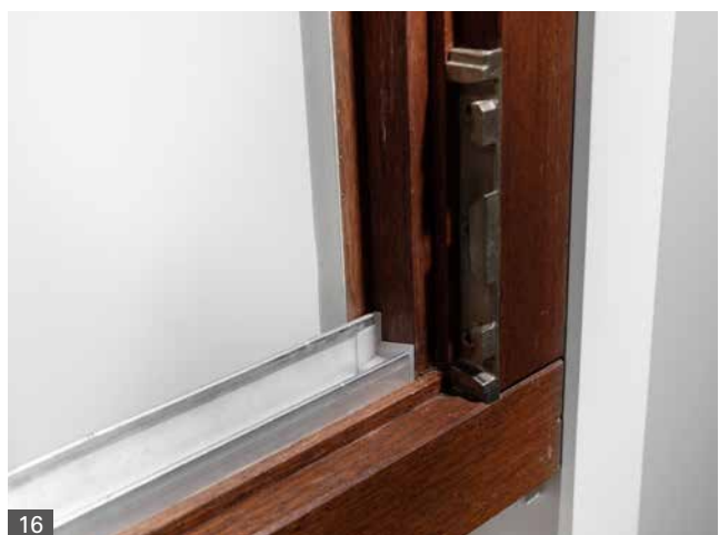
Abb. 16 Holzrahmen mit Schließblech
