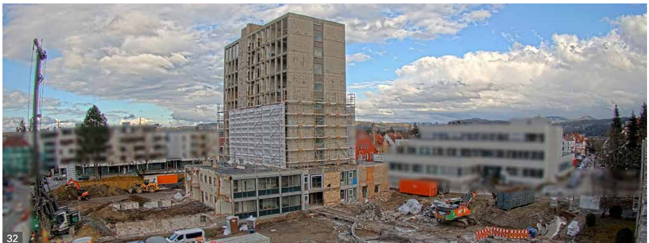
Abb. 32 Das Landratsamt wurde 2024/25 abgerissen.
