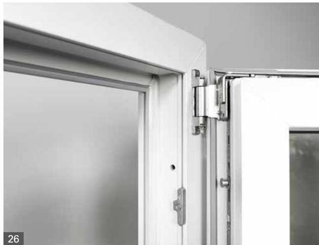
Abb. 26 Detailansicht des oberen Ecklagers und der Falzgeometrie
