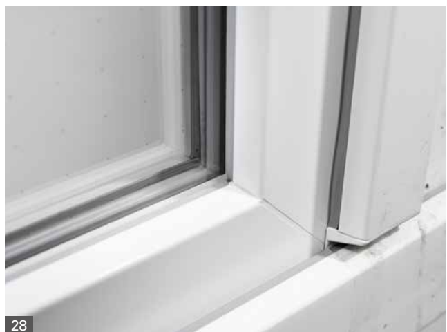
Abb. 28 Glas-Rahmen-Übergang mit Dichtungsebene und Randverbund
